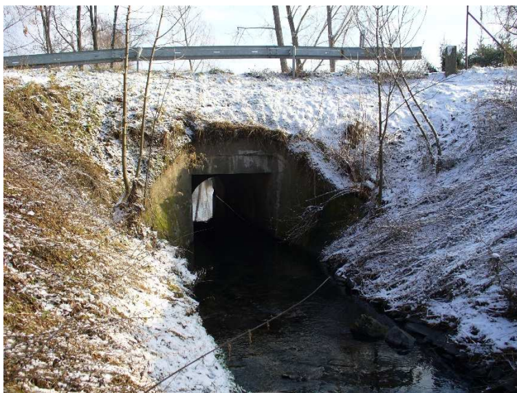
obr. 11 – úsek 05, pohled po proudu na objekt č. 5, ulice Bělomlýnská, navržený k rekonstrukci
